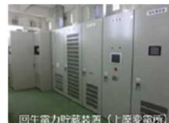
回生電力貯蔵装置（上原変電所）
