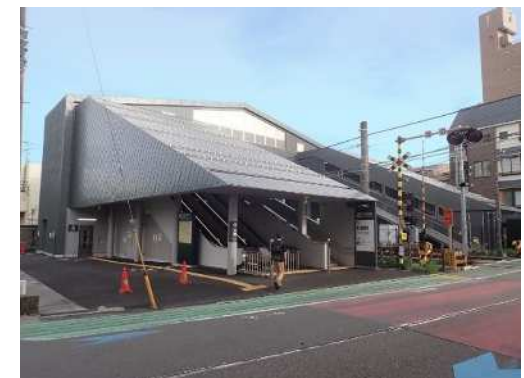
橋上駅舎化されたJR稻田堤駅
