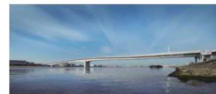
多摩川スカイブリッジ
