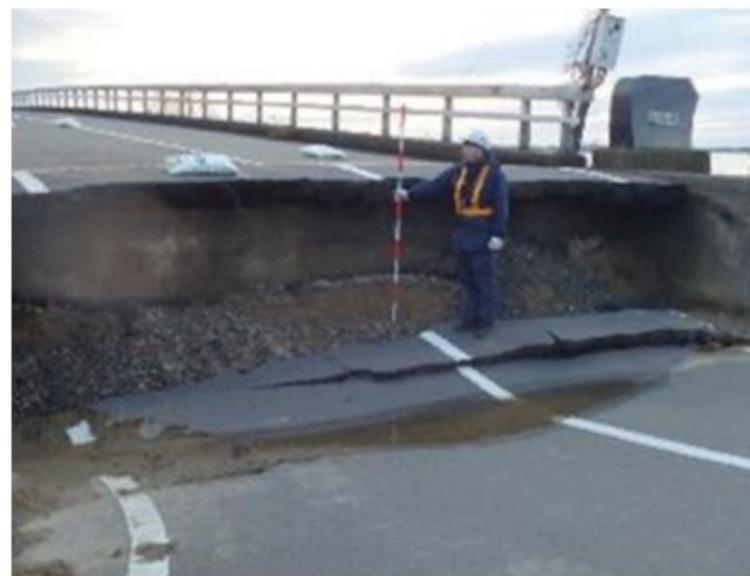
図 能登半島地震での橋りょうの被災状況
