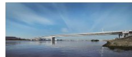
多摩川スカイブリッジ
