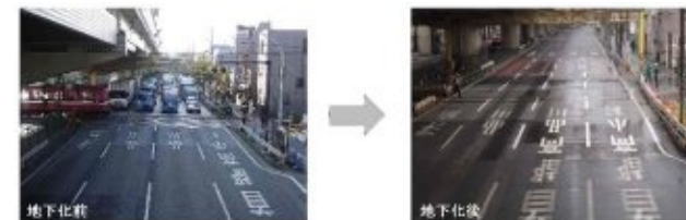
産業道路における踏切の除却
