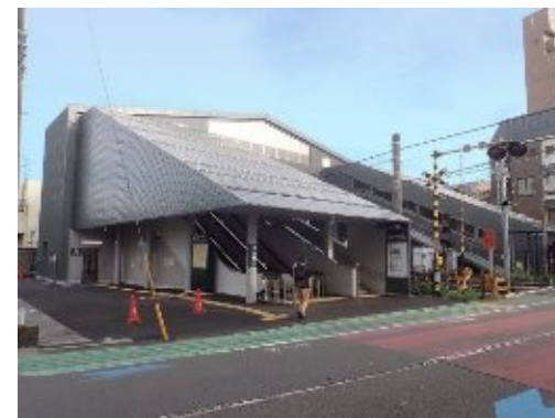
橋上駅舎化されたJR稻田堤駅
