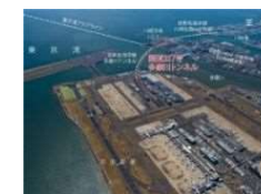
国道357号 多摩川トンネル航空写真 （出典）関東地方整備局 川崎国道事務所資料
