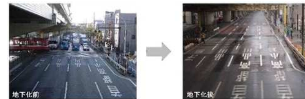
産業道路における踏切の除却
