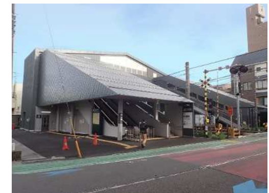
橋上駅舎化されたJR稻田堤駅
