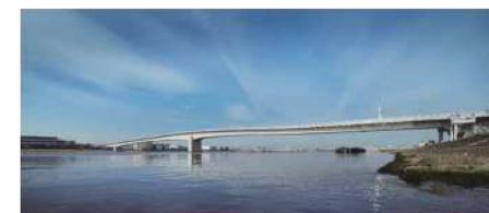
多摩川スカイブリッジ
