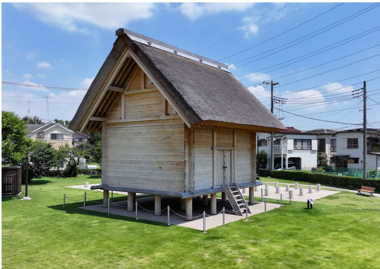
史跡橘樹官衙遺跡群の一部に整備された橘樹歴史公園の復元倉庫（南西から）
