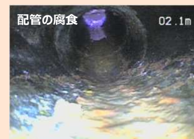
配管の老朽化（給排水設備） ⇒詰まりや漏水の原因となる
