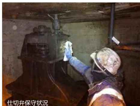
仕切弁保守状況
