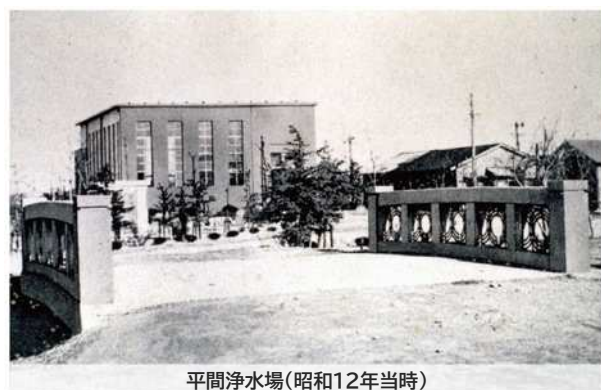
平間浄水場(昭和12年当時)
