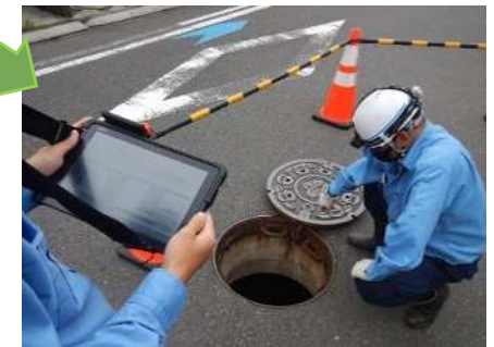
タブレットを用いた管きよの点検
