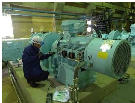
施設の点検(ポンプ設備定期点検)
