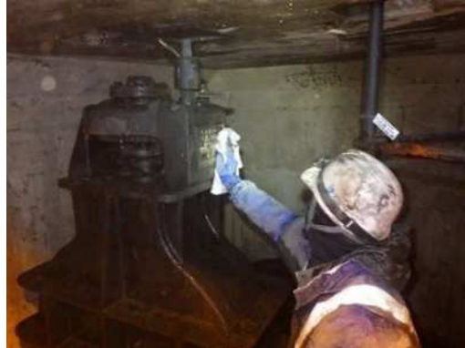
仕切弁保守作業
