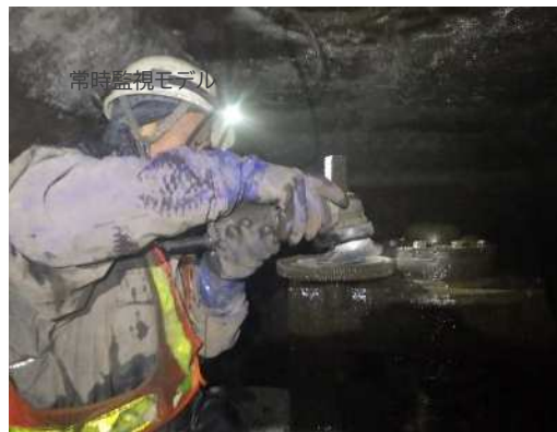
仕切弁保守作業
