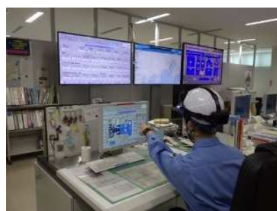
中央監視制御装置による運転管理
