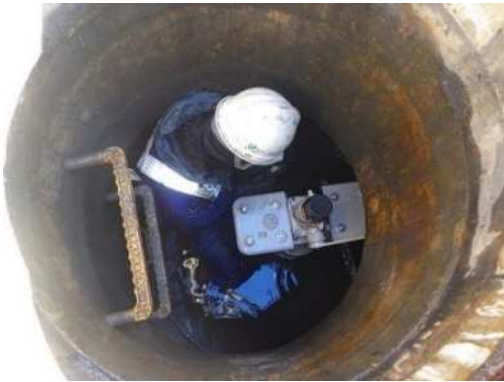
空気弁保守作業
