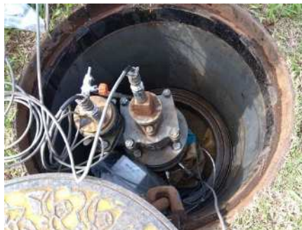
中大口径管路の漏水調査イメージ
