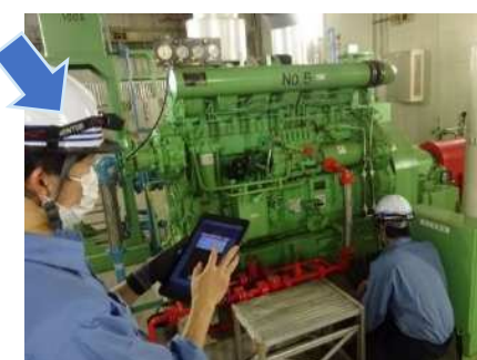
タブレットを用いた設備の保守点検
