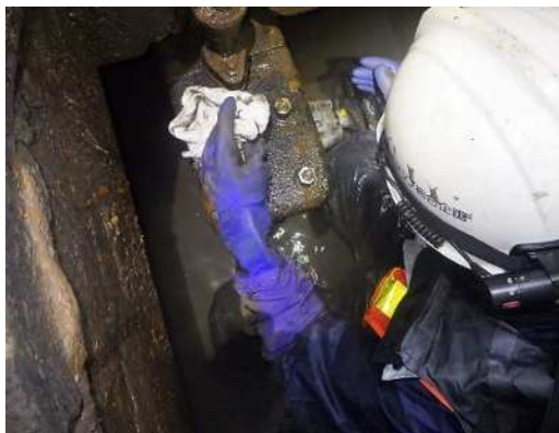
空気弁保守作業
