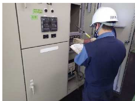
施設の点検(電気設備定期点検)
