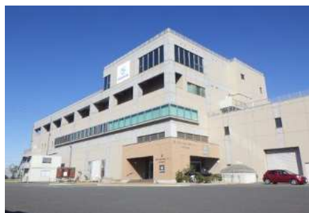
入江崎水処理センター
