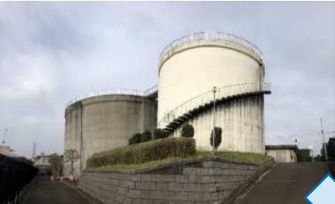
千代ヶ丘配水塔(更新前)
