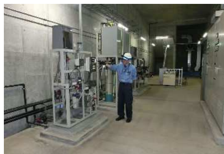
施設の点検(水質計器定期点検)
