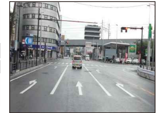
国道409号（小杉御殿町交差点）右左折レーンの新設
