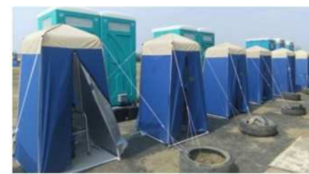
東日本大震災で使用されたマンホールトイレ（宮城県東松島市）
