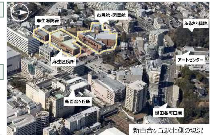
新百合ヶ丘駅北側の現況
