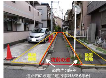
道路内に段差や道路標識がある事例
