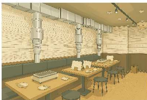
上引き排気ダクト
